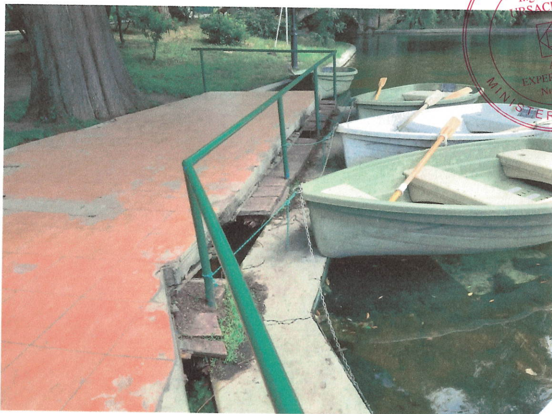
Fig.8 Ponton nou construit dupa 2004 degradat se propune demolarea.
