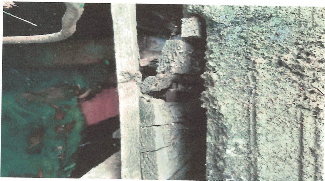
Fig 8. Structura platformei galbene degradată ce riscă să se prăbușească.
