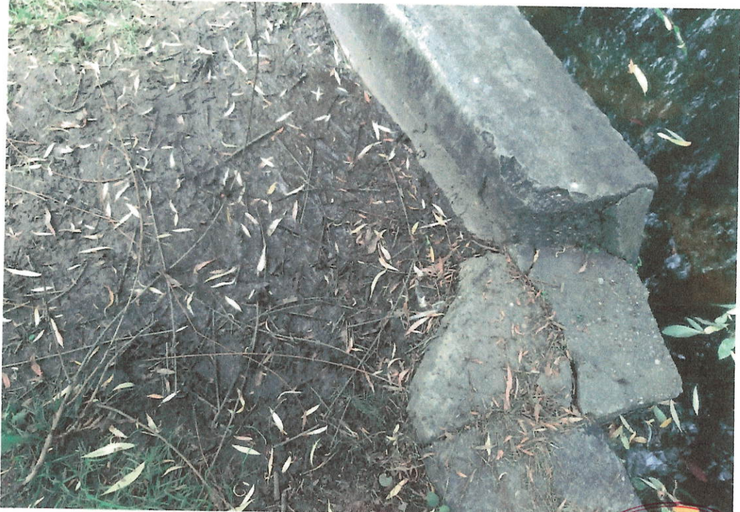
Fig.2. Zona de stagnare apa landa apararea de mal
