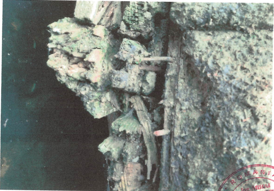
Fig. 9 Structura platformei roz degradata partial cedata, armature la vedere betonul de slaba calitate degradat atacat de agentii din apa lacului
