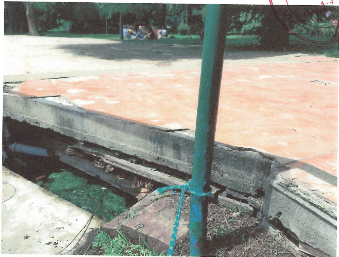
Fig. 9 Structura platformei roz degradata partial cedata, armature la vedere betonul de slaba calitate degradat atacat de agentii din apa lacului
